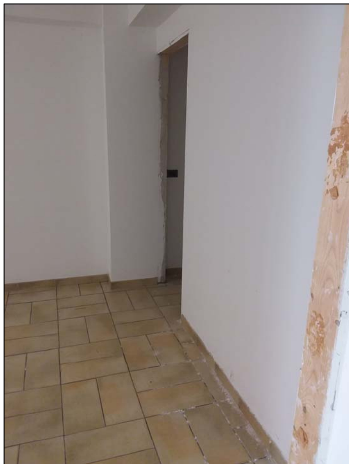
FOTO 43 - INGRESSO RIPOSTIGLIO SOTTOSCALA
